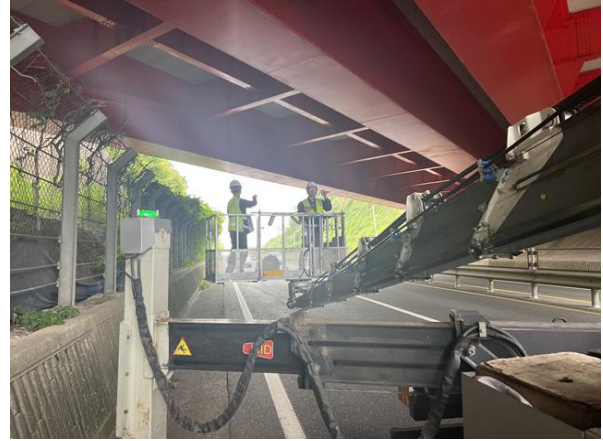
고소차를 이용한 근접조사
