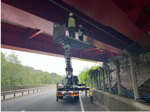
고소차를 이용한 근접조사
