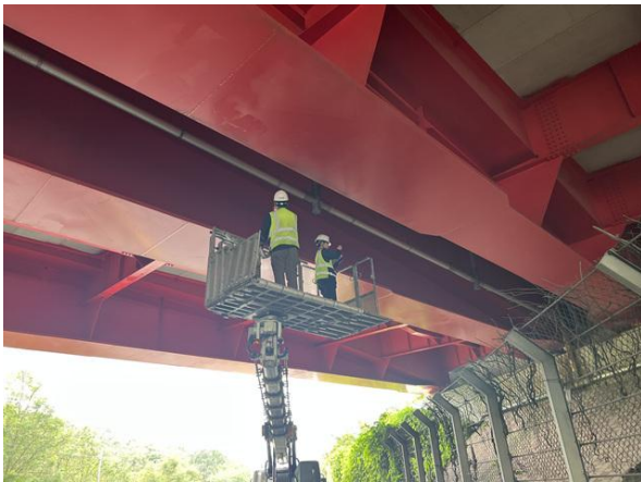
고소차를 이용한 근접조사
